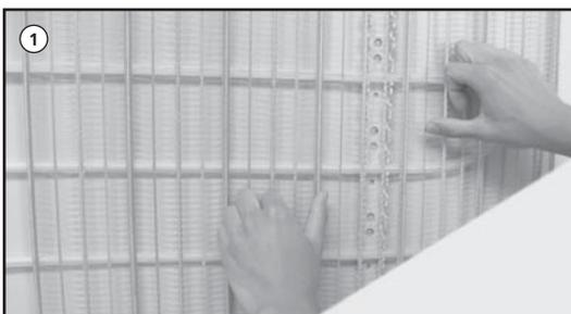
1.-2. Im ersten Arbeitsgang wird das Roth Systemheizrohr mit der Klippschiene mit Putz umschlossen. Anschließend wird eine Putzbewehrung aus Metall oder Gewebe in die frische Putzschicht eingedrückt. Die folgende zweite Putzschicht sollte eine Rohrüberdeckung von 10 bis 16 mm aufweisen.
