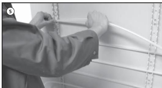
5. Verlegung des Roth Systemheizrohres Clima-Comfort S5 durch Einklippen in die Rohrfix-Schiene (aufsteigend und mäanderförmig).
