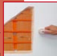
De plaats van Variomodule- buizen kan met de leidingzoeker worden bepaald
