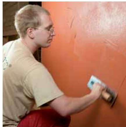
finish. YOSIMA designstuc wordt direct op de leem wapeningsmortellaag aangebracht.
