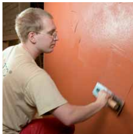
Kwalitatieve droogbouw in leembouw met een hoogwaardige finish. YOSIMA designstuc wordt direct op de leem wapeningsmortellaag aangebracht.
